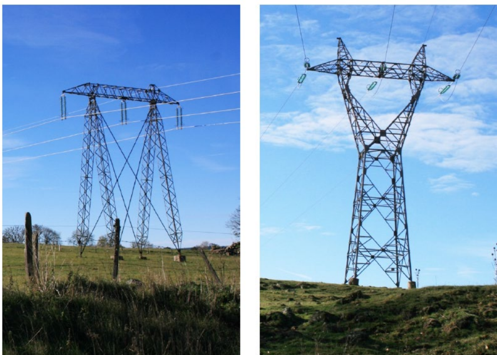
Figure 4 : Exemples de pylônes actuel et futur (source : dossier)
